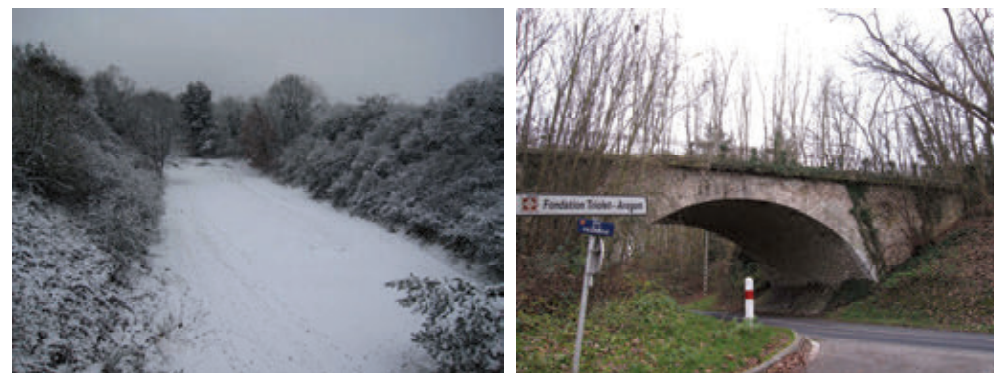
Le passage de l'ancienne voie ferrée en élévation ou dénivelation
