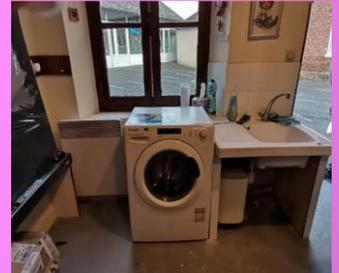
La machine à laver sèche a été déplacée dans les locaux de l'école, pour des raisons évidentes d'ergonomie et de sécurité Radiateur déplacé, branchement électrique et évacuation d'eau créés.
