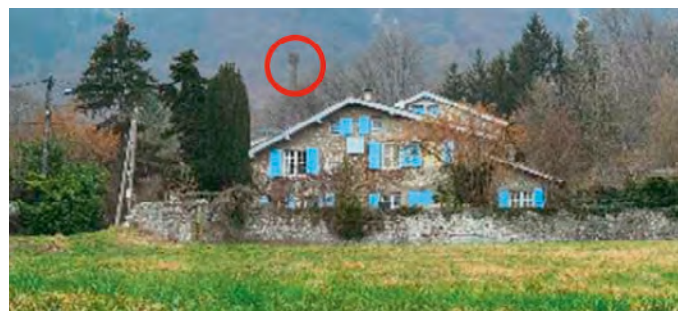
Impact paysager de l'antenne chemin des Chevalières
