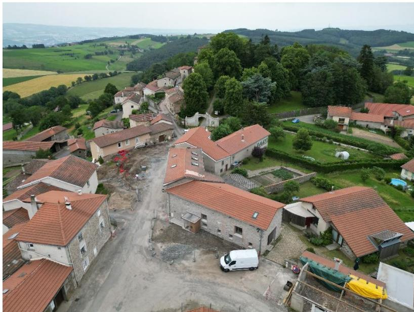
Les travaux ont débuté en août 2022, il y a presque un an, par le renouvellement ou la création des réseaux « humides » (eau potable, eaux usées, eaux pluviales), puis se sont poursuivis par l'enfouissement des réseaux « secs » (électricité, télécom, éclairage public) permettant la disparition des poteaux et le remplacement des lanternes d'éclairage public par la technologie LED.
