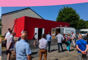
Visite COT ENR Chaufferie Bois à Nouzilly
