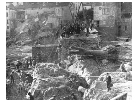
Pont du casino détruit suite à l'aiguat de 1940 ©archives départementales 66
