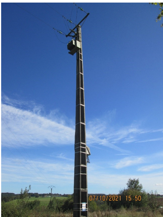
Ci-dessus : APRES travaux – transformateur cabine basse
