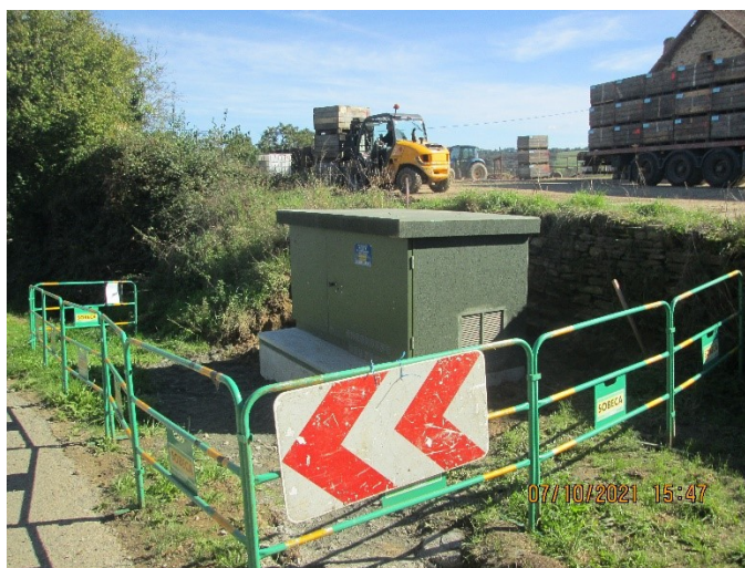
Ci-dessus : APRES travaux – transformateur cabine basse
