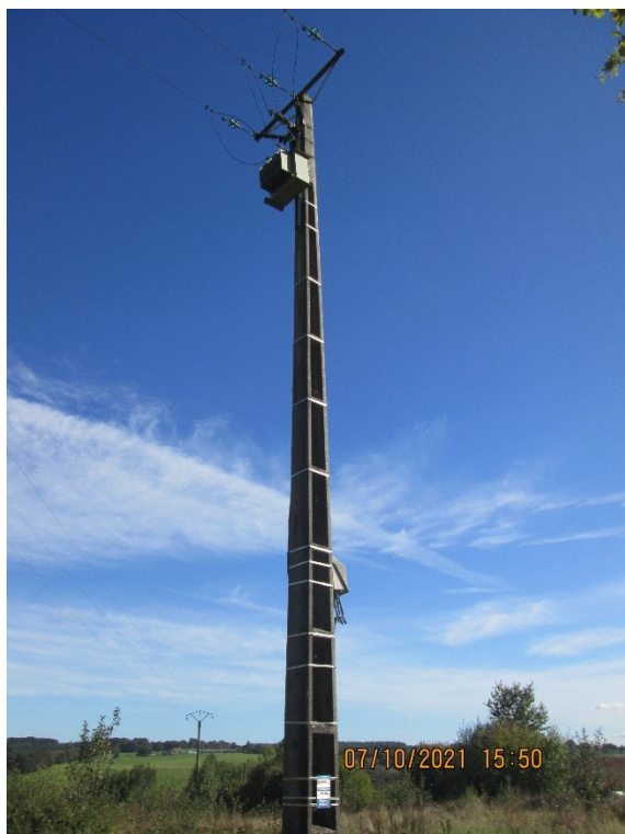
A gauche : AVANT travaux – transformateur sur poteau
