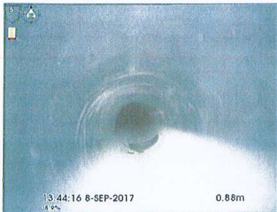
Photo: 3_3_5_A.BMP 0m, Début de l'inspection RV N° REU11
