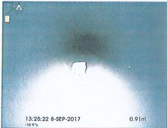
Photo: 1_1_1_A.BMP 0m, Début de l'inspection RV N° REU13
