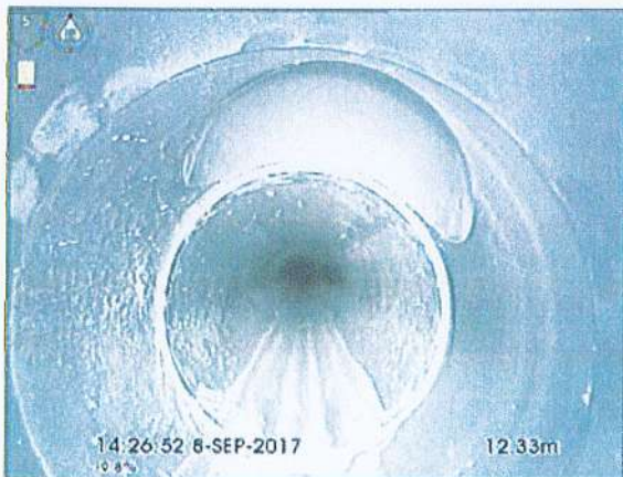
Photo: 9_9_22_A.BMP 12,5m, Raccordement direct à 12 h.
