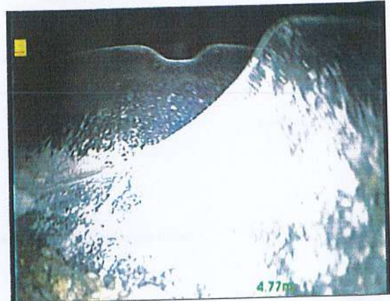
Photo: 30_30_77_A.jpg 5m, Fin de l'inspection du branchement
