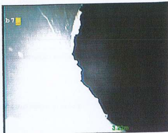
Photo: 19_19_60_A.jpg 4m, Fin de l'inspection du branchement
