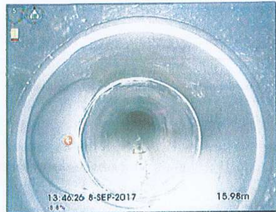
Photo: 3_3_6_A.BMP 16,3m, Raccordement direct à 09 h.
