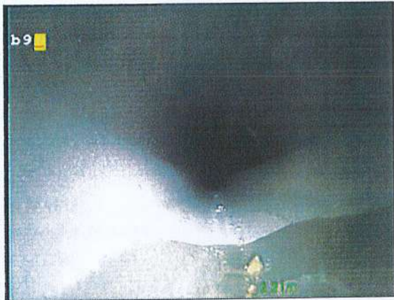
Photo: 21_21_49_A.jpg 0m, Début de l'inspection du branchement
