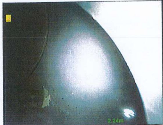
Photo: 24_24_65_A.jpg 3m, Fin de l'inspection du branchement
