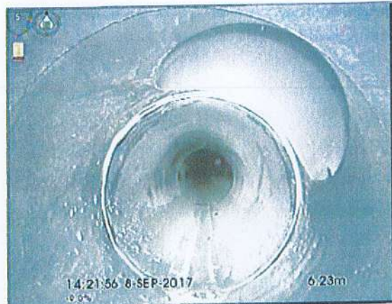
Photo: 8_8_16_A.BMP 6,6m, Raccordement direct à 01 h.
