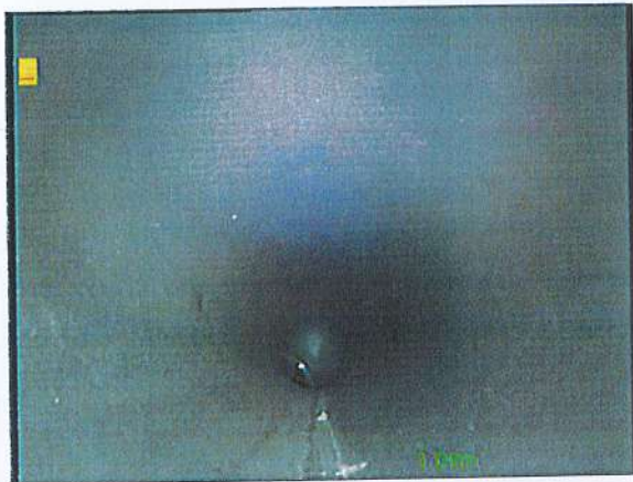
Photo: 29_29_70_A.jpg 0m, Début de l'inspection du branchement
