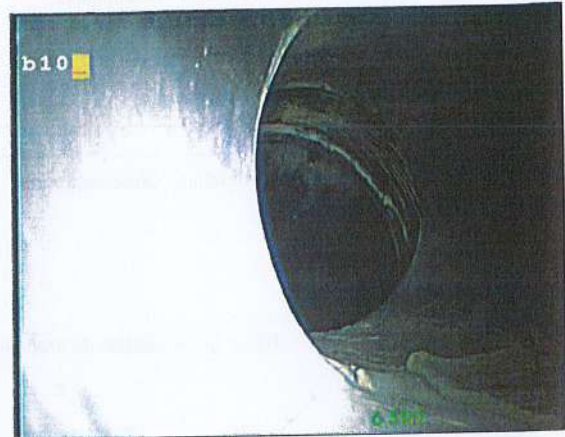
Photo: 22_22_63_A.jpg 7m, Fin de l'inspection du branchement
