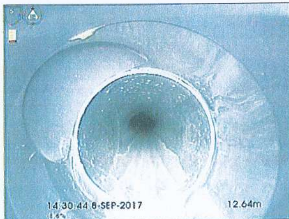
Photo: 10_10_27_A.BMP 13m, Raccordement direct à 10 h.
