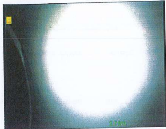
Photo: 29_29_76_A.jpg 2,8m, Fin de l'inspection du branchement
