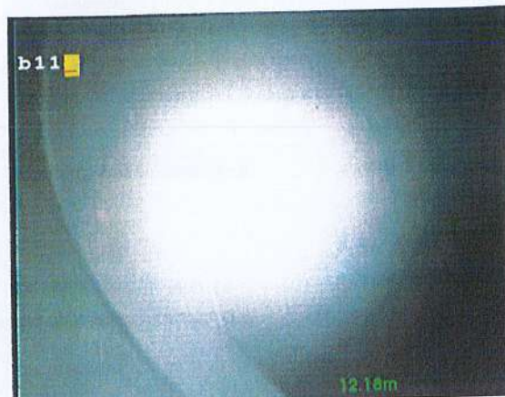
Photo: 23_23_64_A.jpg 13m, Fin de l'inspection du branchement
