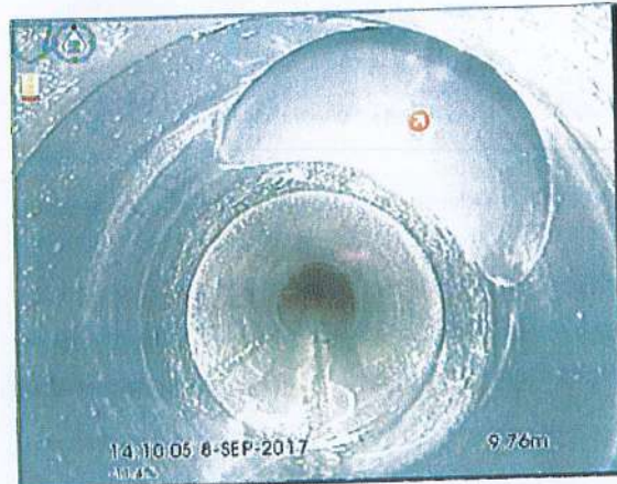
Photo: 6_6_12_A.BMP 10m, Raccordement direct à 01 h.
