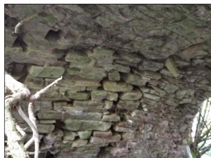
maçonnerie désorganisée et absence de mortier en sous face de la voute
