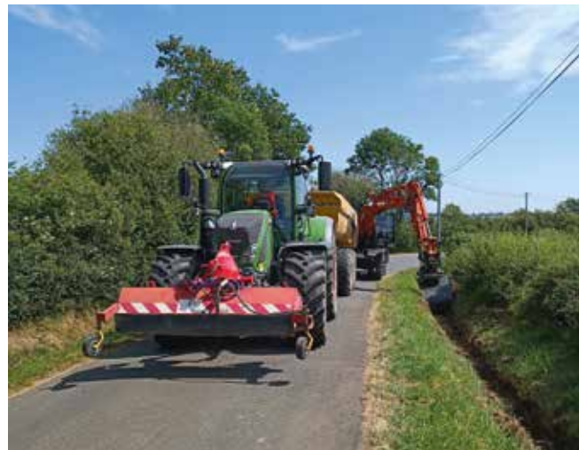
Curage des fossés
