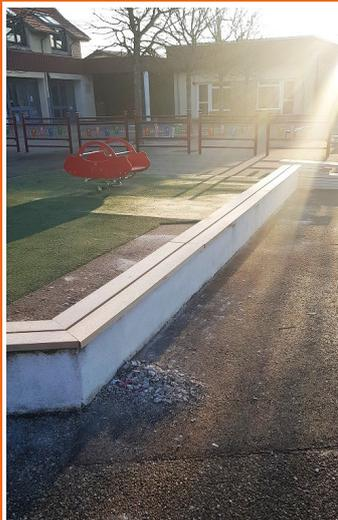
Les couvertines du muret de séparation des cours d'école se descellant progressivement, ce qui devenait dangereux pour les enfants, Dominique et Alexandre les ont remplacées par des bancs en bois. Plus durable, ce sera aussi plus confortable par temps froid ou très chaud.
