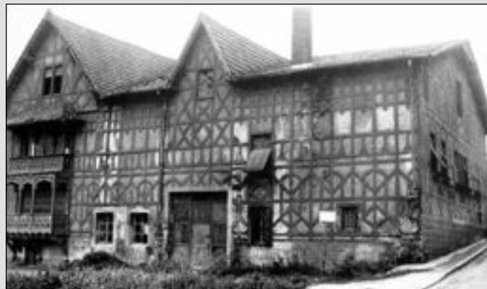
Le « château » de Rombas en 1954, peu de temps avant sa démolition
