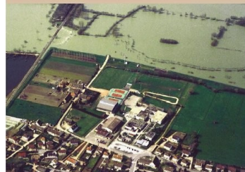
La digue de Saint Marcel (71)
