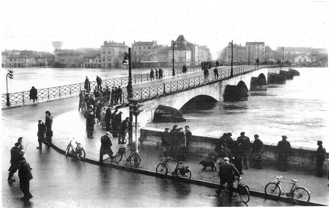
Mâcon, pont Saint-Laurent, crue de 1955
