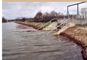
La digue d'Ouroux-sur-Saône (71)
