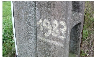
Repère de crue de 1983 à Gray-la-Ville (70)
