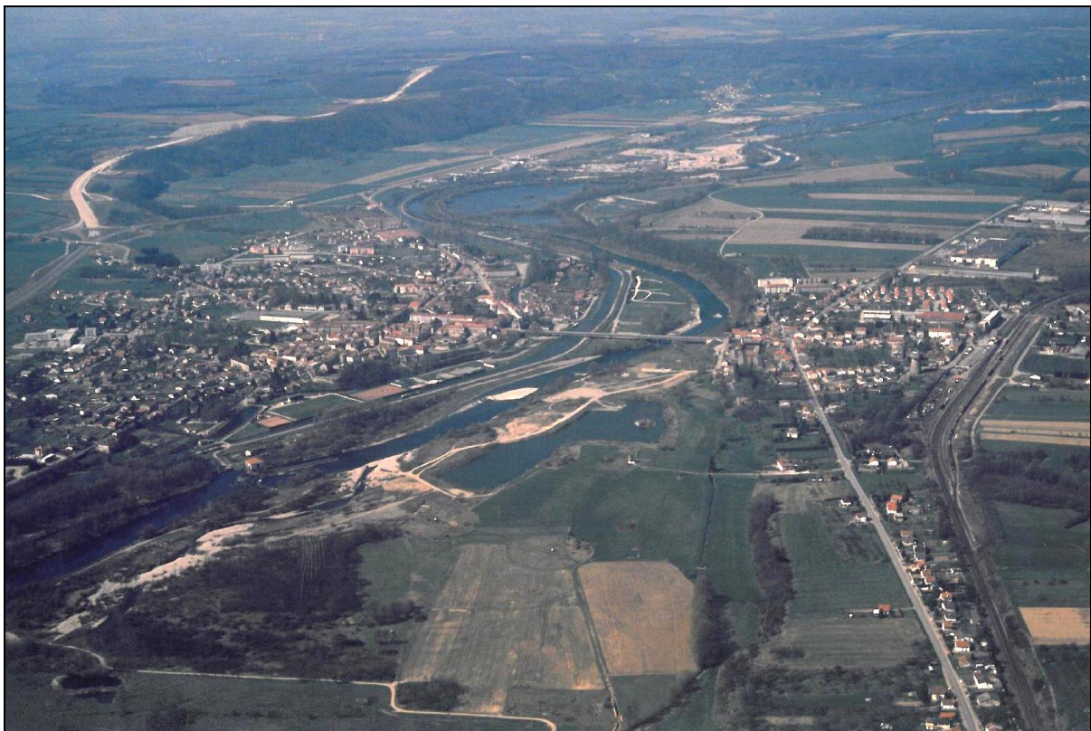
Un territoire marqué par 6 axes structurant renforçant l'effet « vallée » : RN 57, RD 157, le canal, la Moselle, la RD 32-9, la voie ferrée
