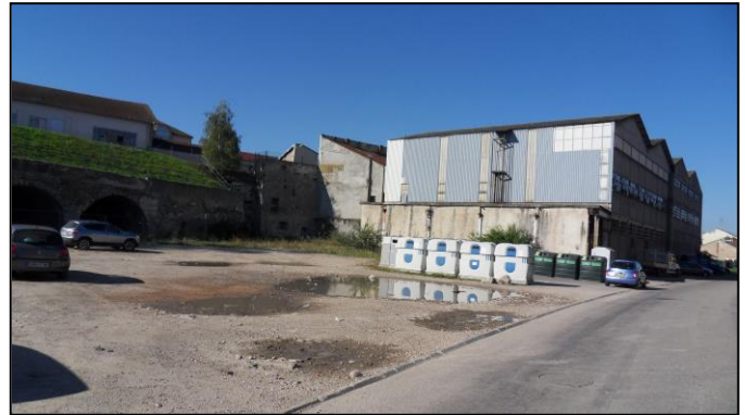
Site des anciennes brasseries : une opération de renouvellement urbain en cours
