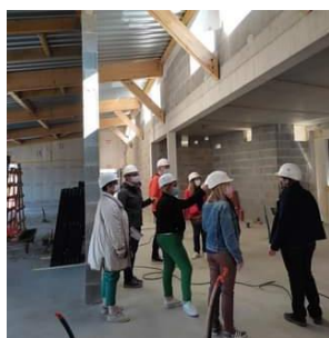
21 septembre : 1 ère visite de chantier
