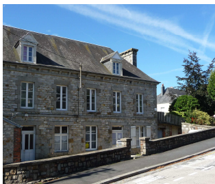
Les locaux ont été aménagés au 1 er étage du bâtiment
