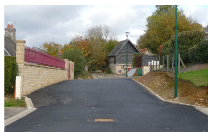
Rue de Versailles - après travaux
