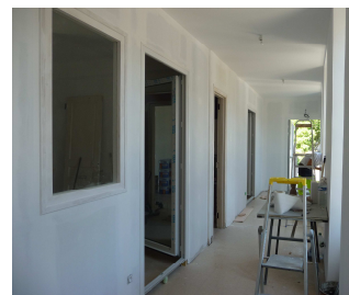
Les locaux pendant les travaux
