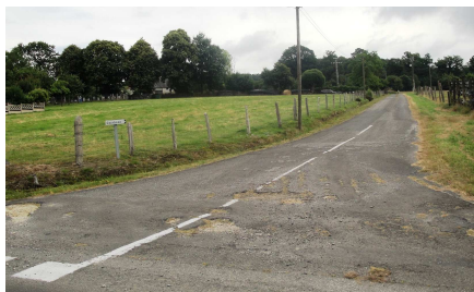
Courbocé - avant travaux
