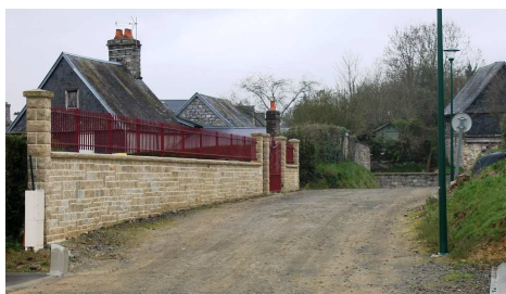
Rue de Versailles - avant travaux
