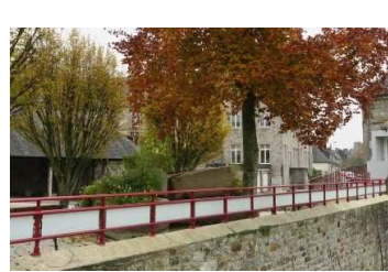
garde-fou (maison de services)
