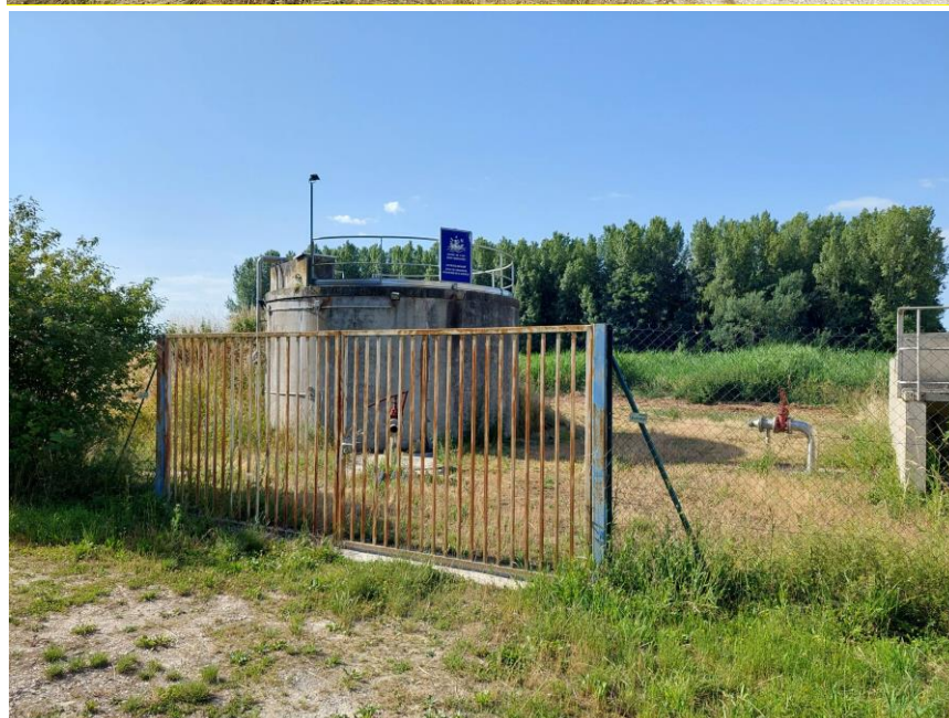
Figure 14 : Station d'épuration de Thiéblemont-Farémont
