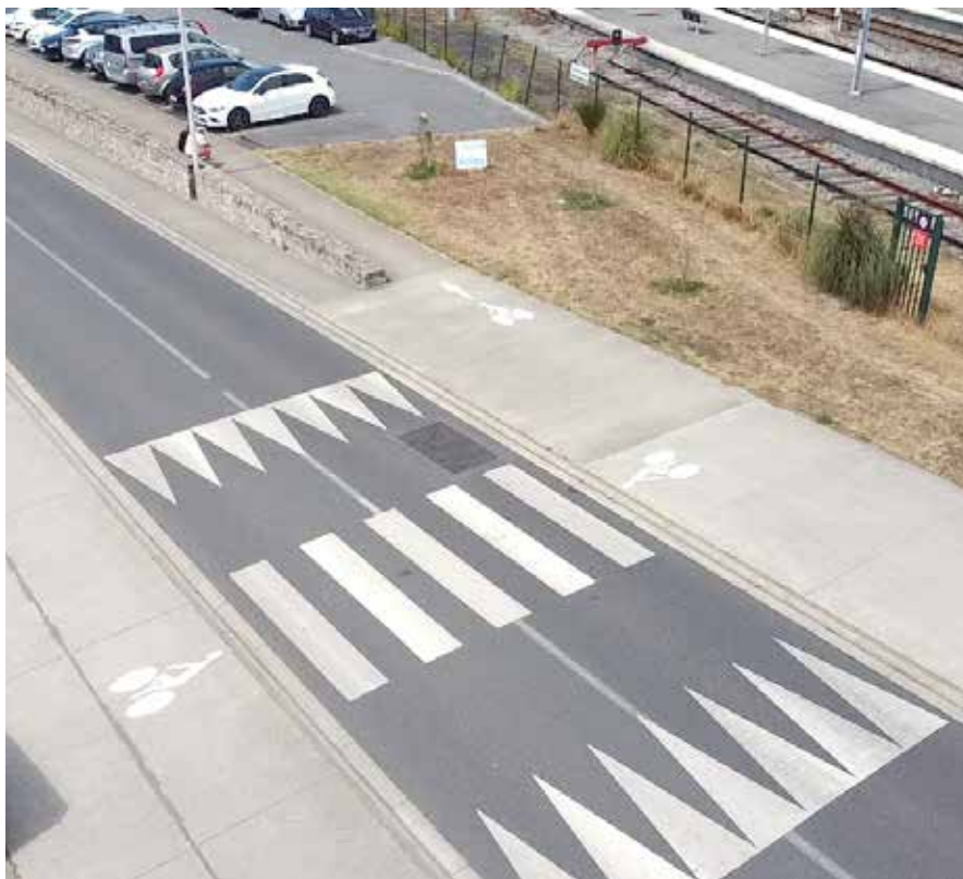
Trompe l'œil d'un plateau avenue Aristide-Briand.
