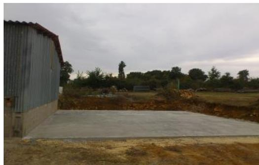
L'atelier était devenu trop exigü. Il a été décidé de l'agrandir. Les agents communaux ont déjà coulé la dalle de béton et une entreprise va venir poser la charpente métallique. Le soubassement en parpaings et le bardage seront réalisés par les agents.
