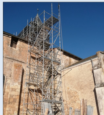
L'échafaudage pour travaux de la flèche
