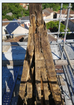
La flèche avant les travaux
