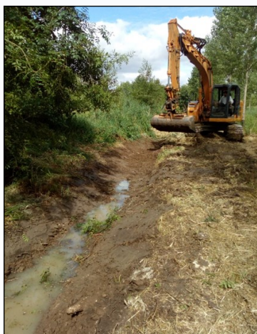
Fossé profilé en pente douce, perpendiculaire à la Clouère, pouvant servir de frayère à brochets.
