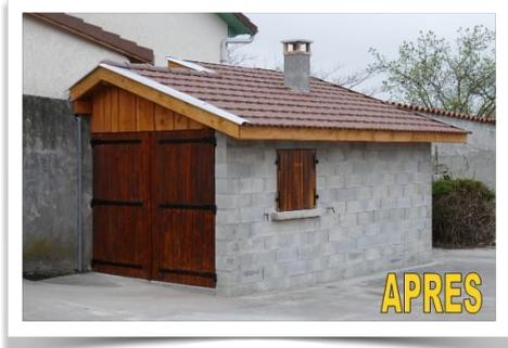
Petite pause pour l'équipe ayant réalisé la construction du four. Celle-ci étant nécessaire au séchage de la maçonnerie avant l'application de l'enduit de façade et les travaux de finitions à l'intérieur du bâtiment. Sinon le four est opérationnel car il est désormais hors d'eau. La première flambée aura lieu dans quelques jours. Elle sera douce afin de sécher au maximum l'humidité présente dans le corps du four sans pour autant l'altérer.
