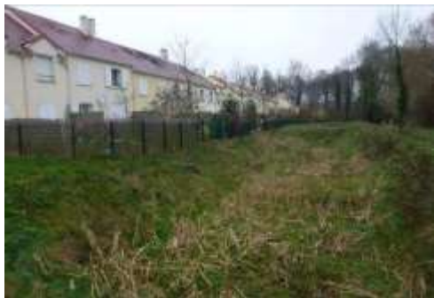
Bassin de rétention près du ru de Frileuse
