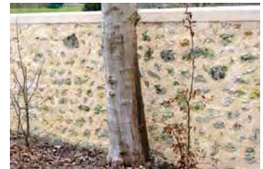
ENDUIT À PIERRE VUE DONT LES JOINTS SONT « BEURRÉS »
