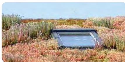
UNE TOITURE QUI VARIE SELON LES SAISONS
