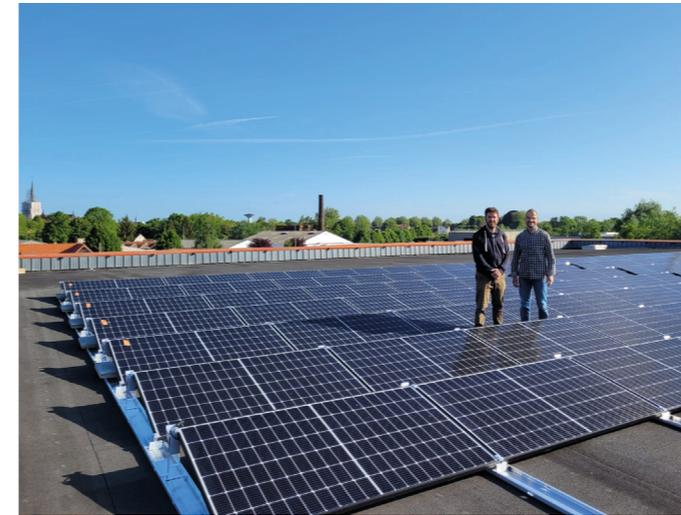
La centrale photovoltaïque de 36 kWc est composée de 96 panneaux solaires. 8 de ces panneaux sont directement branchés sur la salle Festi'Val en autoconsommation totale : une volonté marquée de la commune d'agir pour la transition énergétique.
