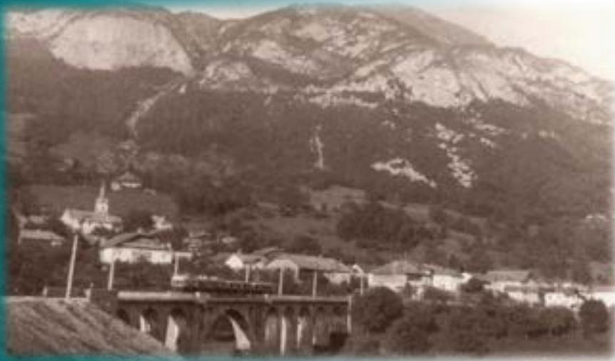
Le viaduc de Mieussy a été construit en 1931, il mesure 126 mètres de long, et comporte une arche centrale de 24 mètres d'ouverture dominant le Foron de 20 mètres. Jadis, il permettait le passage d'un train reliant Annemasse à Sixt. Le viaduc est fermé aux véhicules motorisés, il n'est accessible qu'aux piétons et cyclistes.
