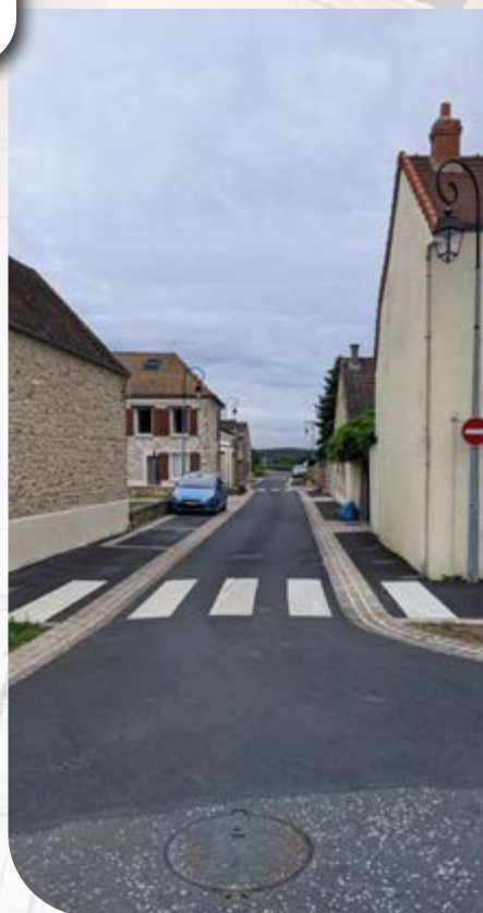
Rénovation de la rue de Villarceau
