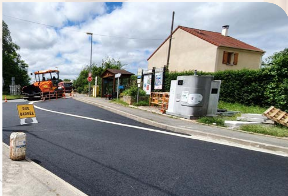
Réfection des voiries (exemple : chemin du ruisseau blanc)
