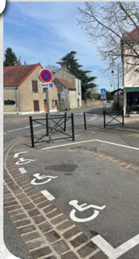
Réalisation de place PMR
