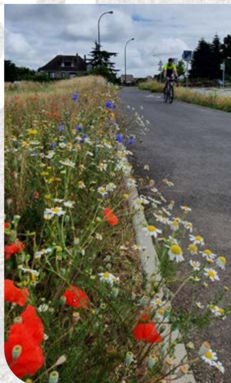
Réalisation d'une voie verte reliant Nozay au Data 4
