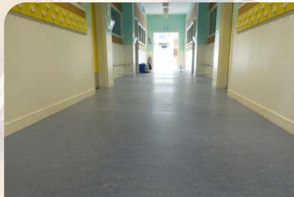
Réfection des sols à l'école du Petit Gobert
