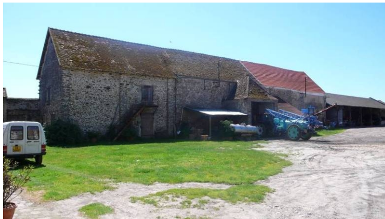
CHE01 : grange possédant une porte charretière précédée d'un porche permettant de faciliter les manœuvres agricoles
