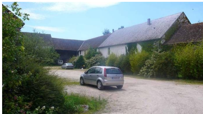
CHE28, située au 14, rue Saint-Martin
