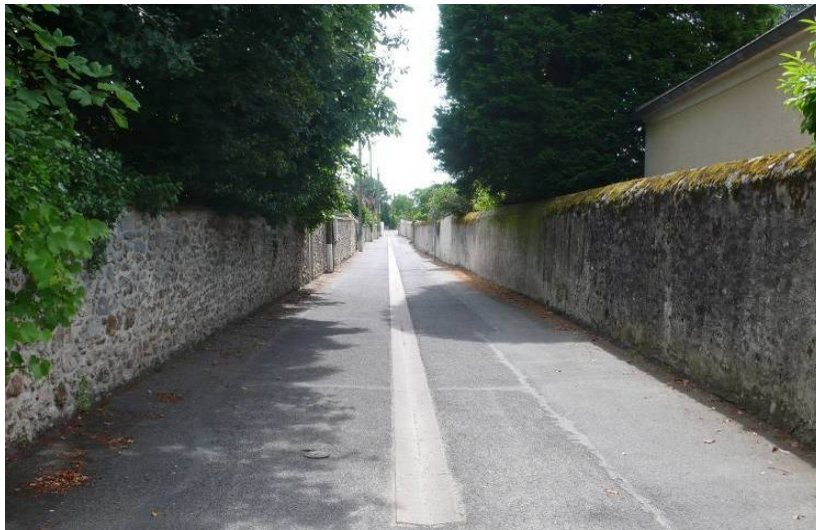
Murs de clôture en pierre de la ruelle Martin-Denis
