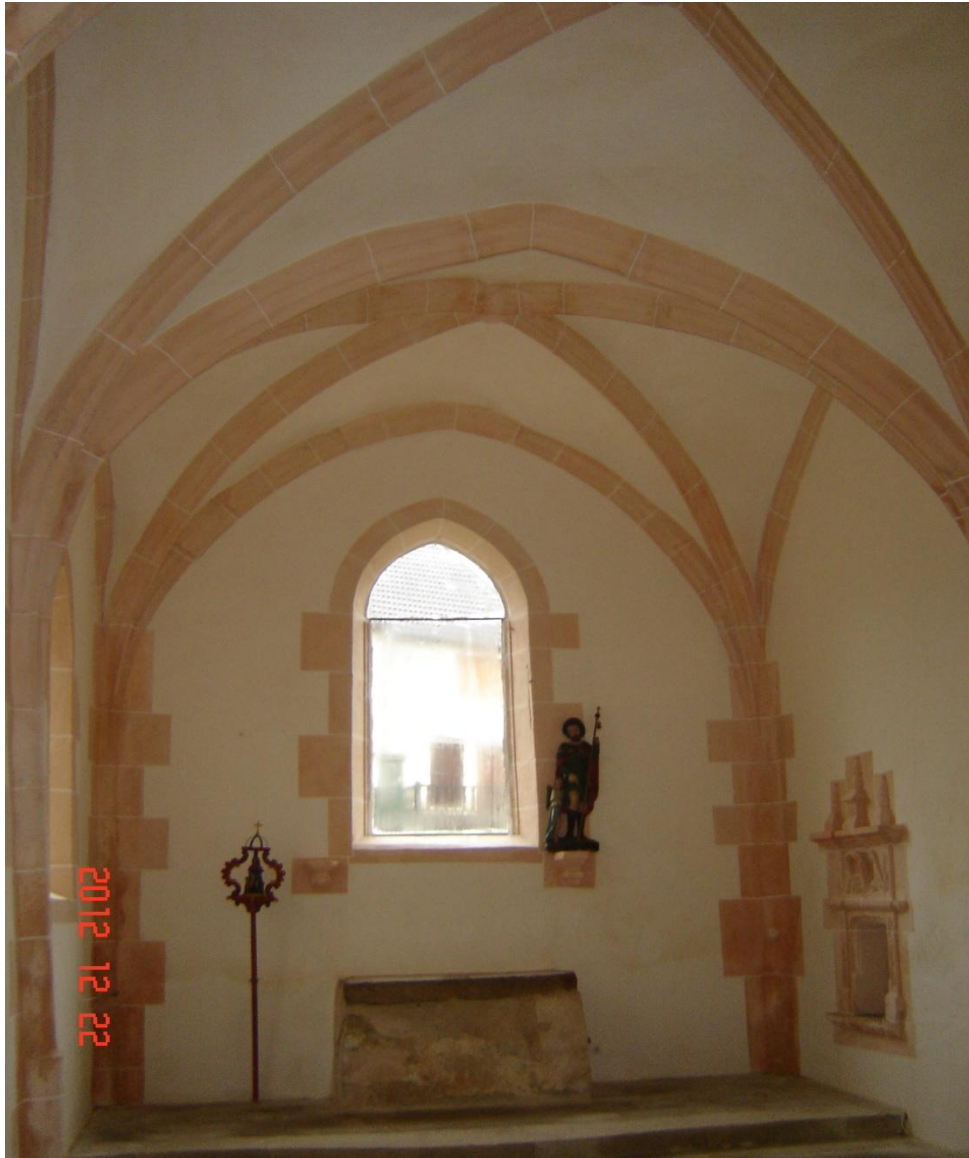
(L'intérieur restauré de la chapelle du Beugnon)
