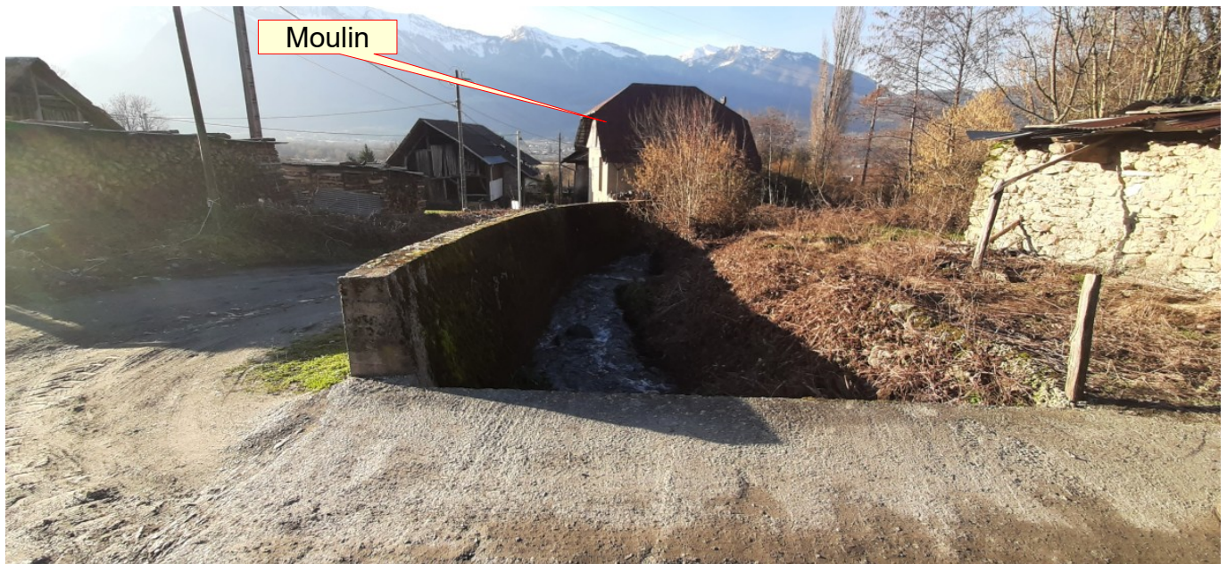
Figure II.7: A l'aval du ponton, débute un lit très contraint dans un secteur assez densément urbanisé.
