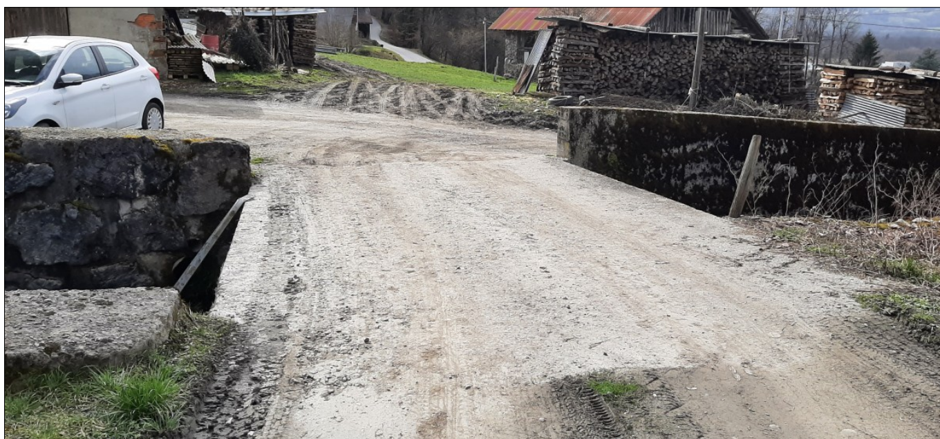
Figure II.6: Interruption de la digue rive gauche au niveau du Ponceau de Viplanne.
