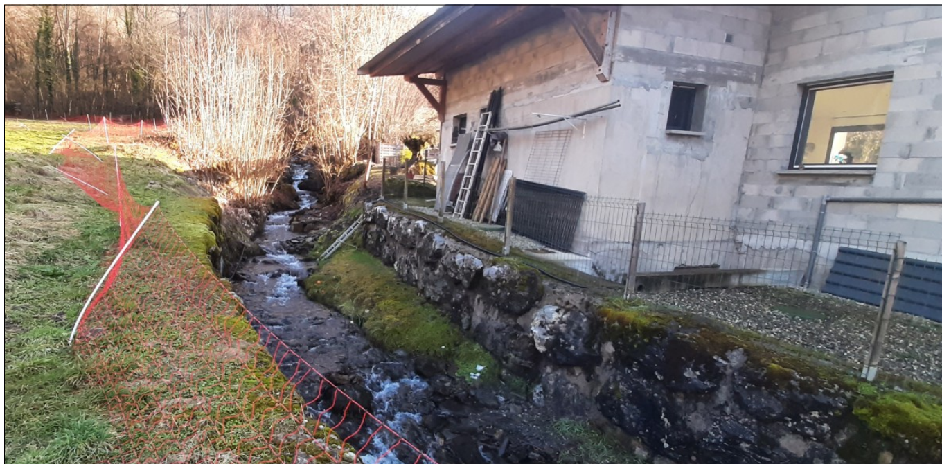
Figure II.5: A partir de ce point, le lit de La Combaz est artificialisé.
