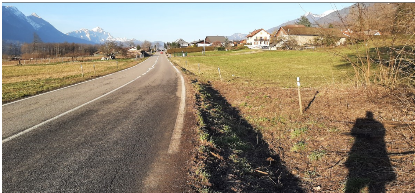
Figure III.7: Fossé de route en amont de la RD 925 (vue vers l'Est).
