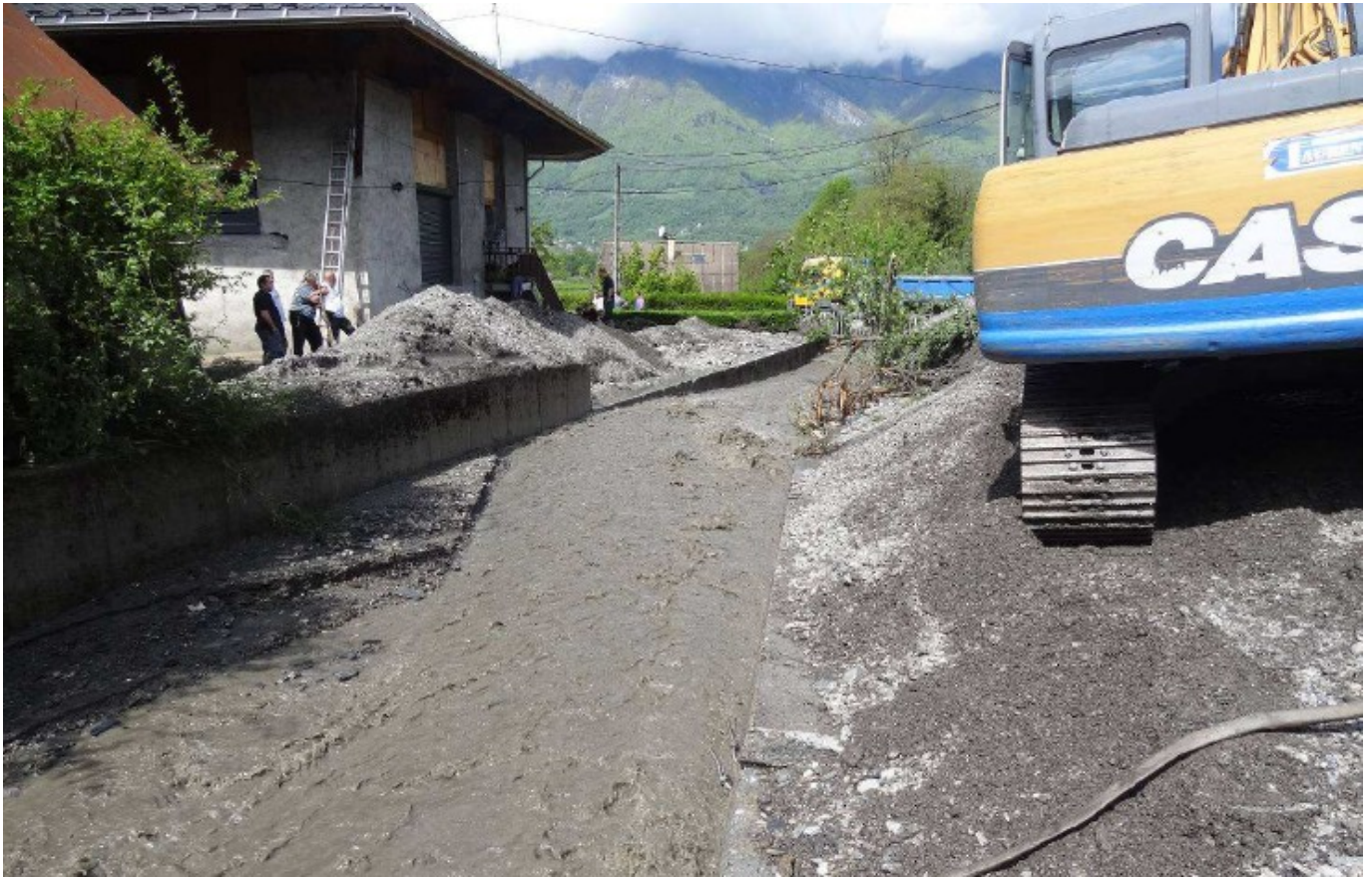
Figure II.10: Lit engavé en amont de la RD 925 en 2015.
