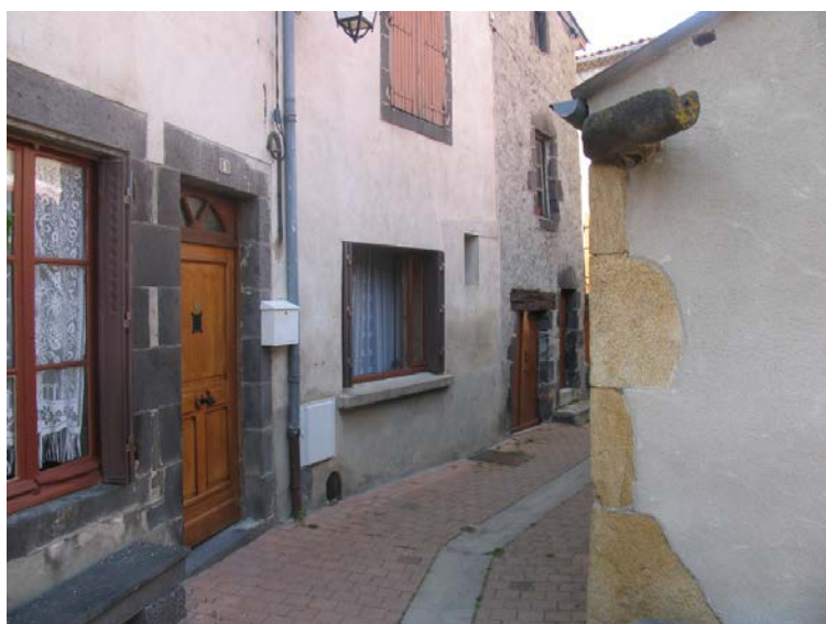
Exemple de façade : enduits fins, grattés et pierres apparentes
