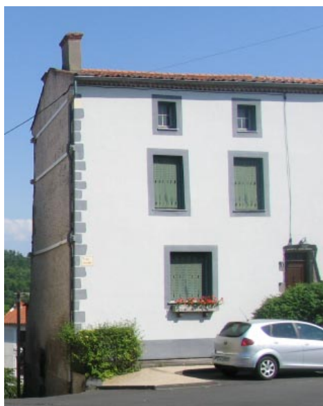
Exemple de façade enduite peinte
