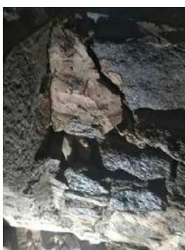
Reprise des joints de pierres à l'intérieur du clocher.
