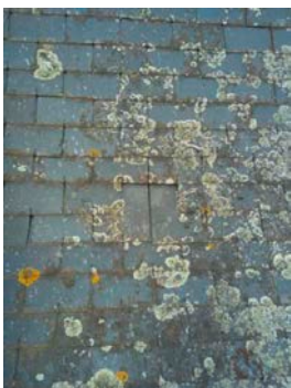
Remplacement de l'ardoise manquante sur le pan inférieur.
