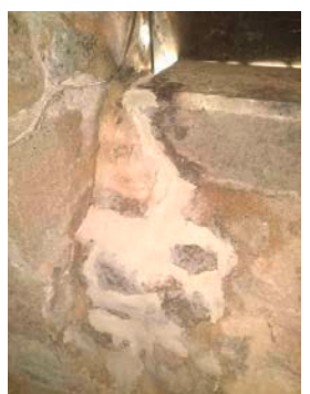
Reprise des joints de pierres à l'intérieur du clocher.
