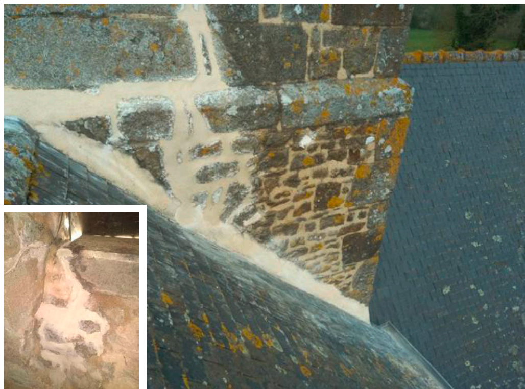
Reprise des joints de pierres à l'intérieur du clocher.
