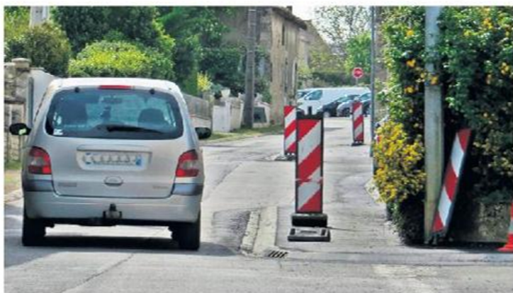
En matière de voirie, la réalisation d'une écluse permet d'élargir un passage pour les piétons. (Photo NR)
