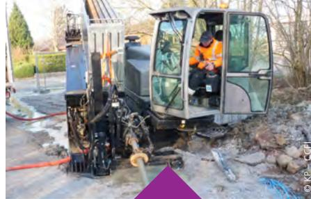
Des travaux un peu spéciaux se sont déroulés à Steenvoorde, dans le cadre de l'aménagement de la zone d'activités du Pays des Géants : un double forage sous l'autoroute A25 pour les conduites d'assainissement et d'eau potable de la future zone gérée par la CCFI !
