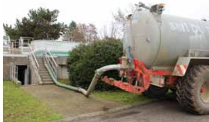
Transfert des boues liquides de Guémar en citerne de 18 m<sup>3</sup> et dépotage à la station d'épuration de Colmar-Ladhof dans les cuves d'épaississement, par le prestataire Philippe Umbdenstock.
