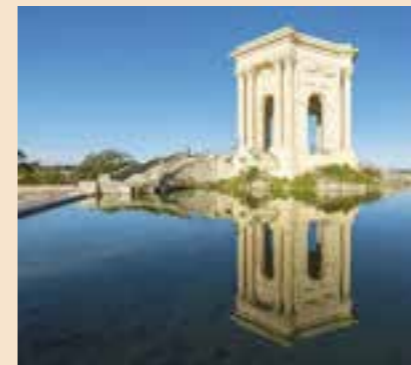
Château d'eau du Peyrou à Montpellier
