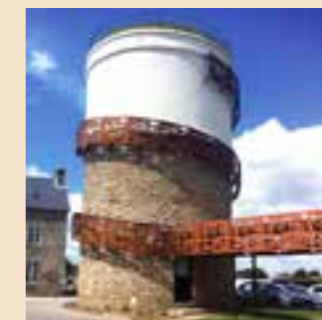
A Uzel-Près-l'Oust dans les Côtes-d'Armor, il a été transformé en centre culturel et est relié à la mairie par une passerelle.
