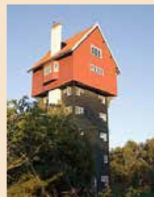
A Thorpeness, dans le canton de Suffolk en Angleterre, ce château d'eau est désormais nommé "House in the clouds - Maison dans les nuages" et abrite un hôtel "bed & breakfast".
