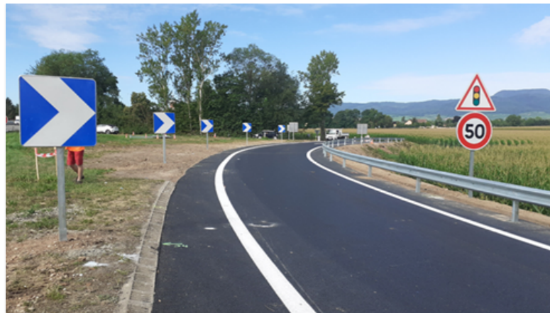
Des aménagements de sécurité sur l'échangeur de Guémar pour 600 000 €.
