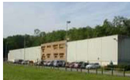
Station d'épuration Rue GAMBETTA à VILLENVOY
