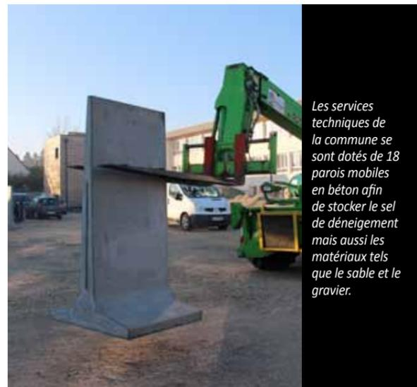
Les services techniques de la commune se sont dotés de 18 parois mobiles en béton afin de stocker le sel de déneigement mais aussi les matériaux tels que le sable et le gravier.
