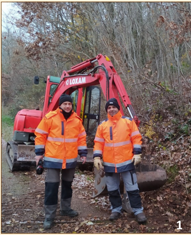
1 Pelleteuse (de location), chemin du Kaeferloch
