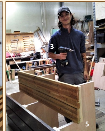
5 Nouvelle estrade pour benne de collecte de déchets verts
