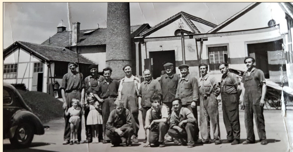
Devant l'ancienne chaufferie au charbon (années 50)
