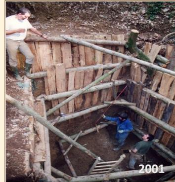
**2001** : poursuite des travaux de déblaiement, boisage et mise en sécurité du 2<sup>e</sup> puits dans des conditions très difficiles, découverte de preuves de l'existence d'un système d'exhaure, pose de rails vers les grands dépilages.
