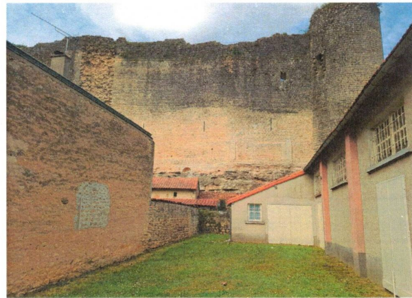
Vue sud des restaurations ayant eu lieu sur la partie orientale de l'enceinte sud (Cliché : C.ARMAND©)
