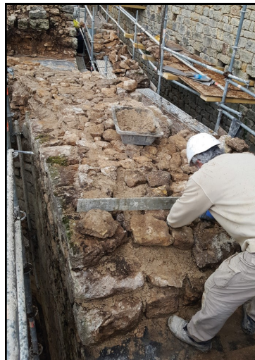
Restauration des arases
