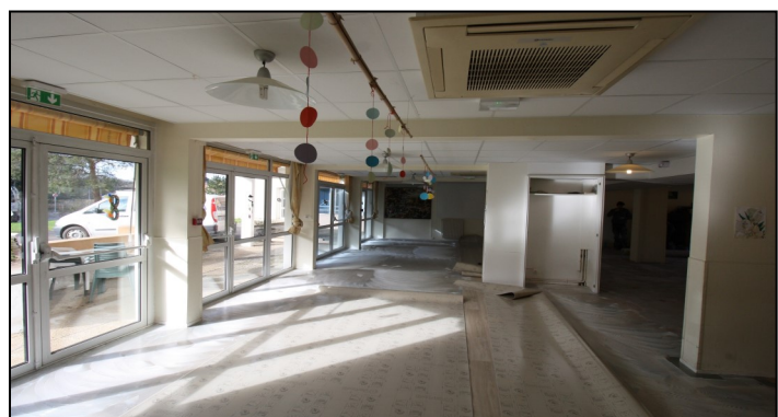
Réfection de la salle à manger
