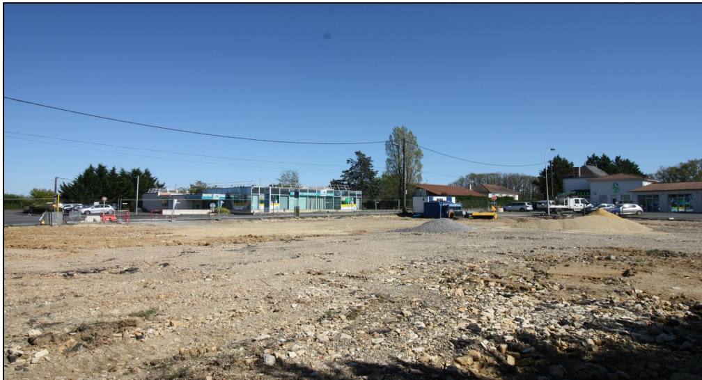
Aire réservée la construction du cinéma
