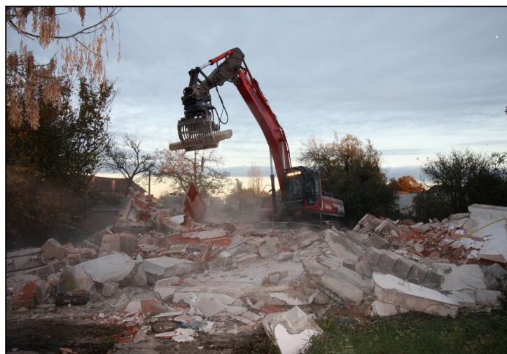
Démolition de la maison de la rue du Huit Mai
