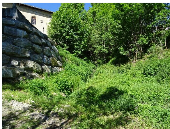
Cours d'eau busé jouxtant le site
