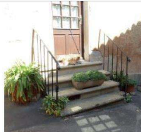
Végétalisation de pied de porte
