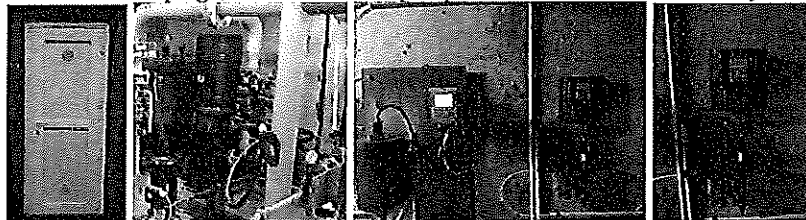
Renouvellement de la porte d'accès au captage, du moteur de la pompe P1 et installation d'un analyseur de chlore (2016) :
