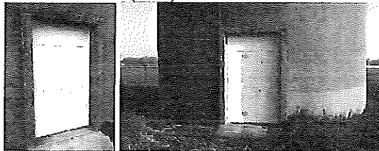
Renouvellement de la double porte d'accès au réservoir (2016) :
