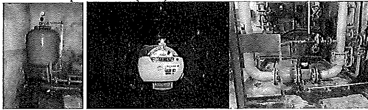
Renouvellement de l'anti bélier et du compteur AESN (2014) :
