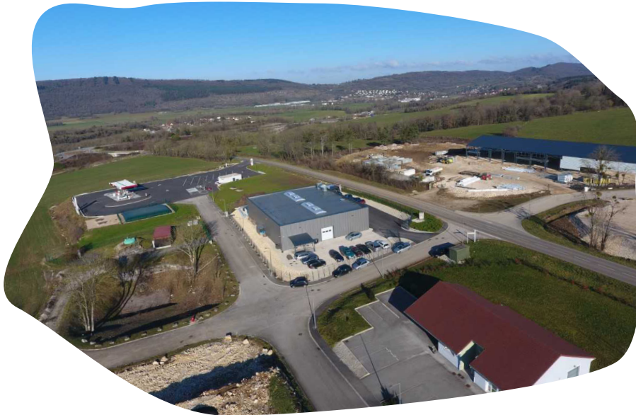
ZA intercommunale de la Combe Parnette à Lavans-Quingey
