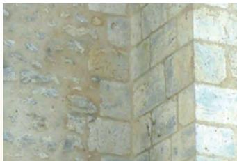
*Les pierres de taille constituent les contreforts et les encadrements des ouvertures. Soigneusement taillées dans la roche, elles ne sont pas couvertes par l'enduit.*
