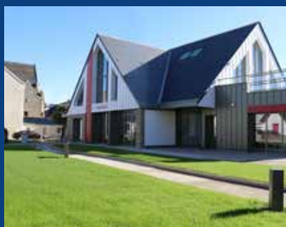
médiathèque Le Traict d'encre
